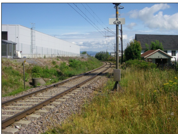
Figur 4: Sikt fra nedsiden av planovergangen, mot Gjøvik.
