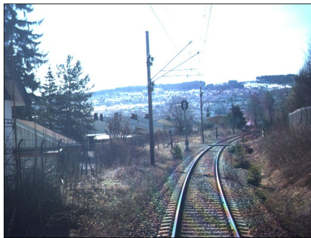
Figur 3: Viken planovergang sett i retning fra Gjøvik stasjon. (Foto: Jernbaneverket)
