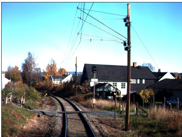
Figur 2: Viken planovergang sett i retning mot Gjøvik stasjon. (Foto: Jernbaneverket)
