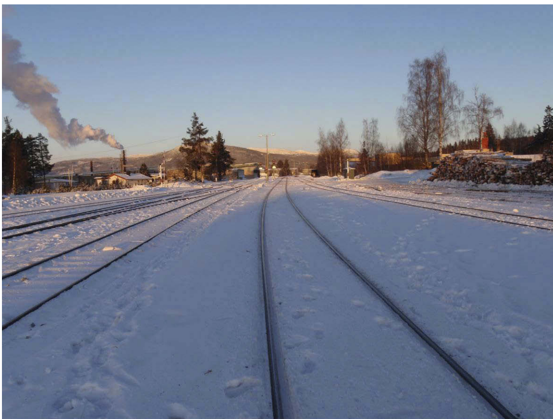
Figur 6: Sporarrangementet i nordre ende av Koppang stasjon. Bildet er tatt ved spor 1.
