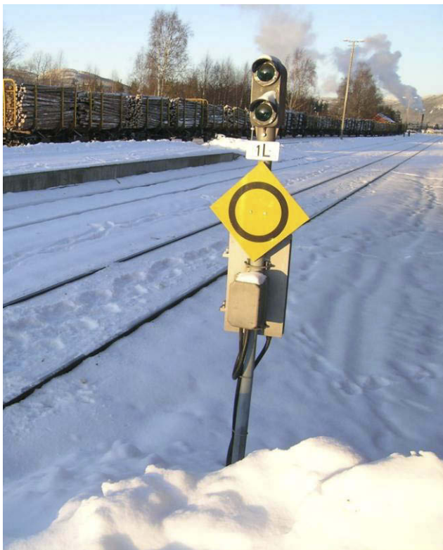
Figur 10: Viser skilt nr. 60D der repeterbaliser er plassert. (Balisene ligger under snøen midt i sporet til
