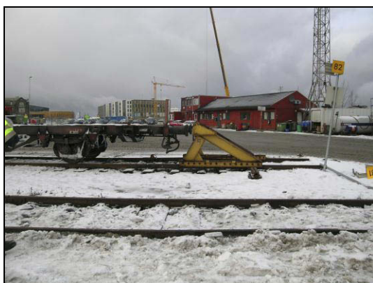
Figur 1: Viser endebutt i spor 82.
