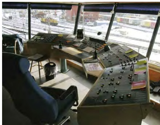
Figur 17: Arbeidsplassen ved Westinghouse slippstillverk. Manøverpanelet for bremsene til venstre.
