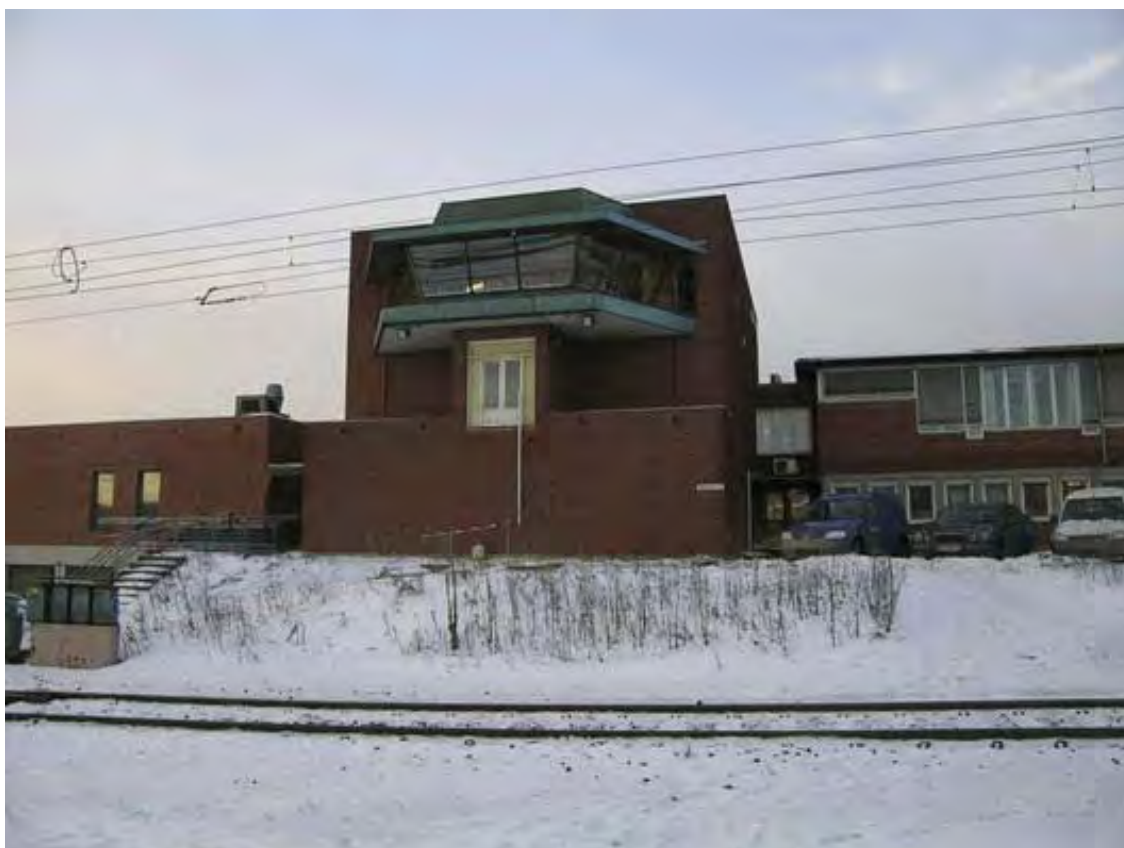
Figur 9: Sentralstillverket på Alnabru
