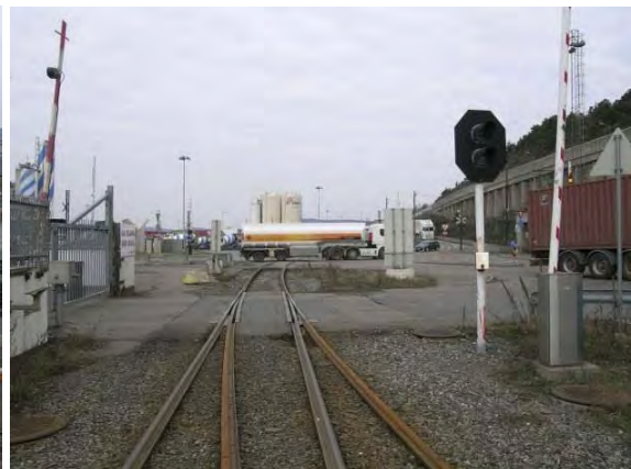
Figur 11: Rundkjøringen i Sjursøyakrysset sett nordover.
