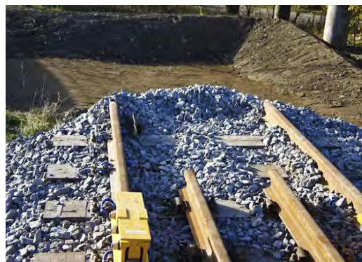
Figur 26: Sandbasseng etter glidbar sporstopper. (Foto: Jernbaneverket)
