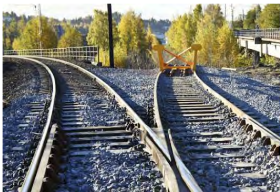
Figur 25: Ny avledende sporveksel ved Alnabru Syd. (Foto: Jernbaneverket)
