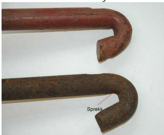
Figur 9: bilde av strekkbolt med sprekk og ny strekkbolt.
