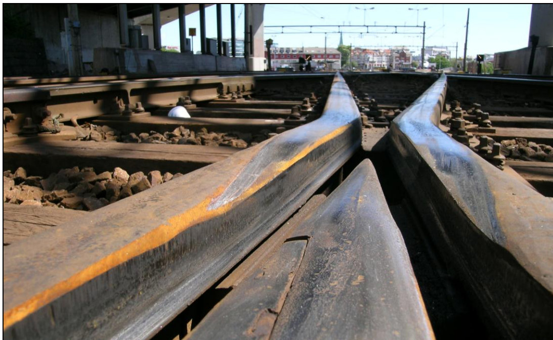
Figur 9: Viser normal slitasje i sporkrysset i spurveksel 3, som ligger etter avsporingsstedet.
