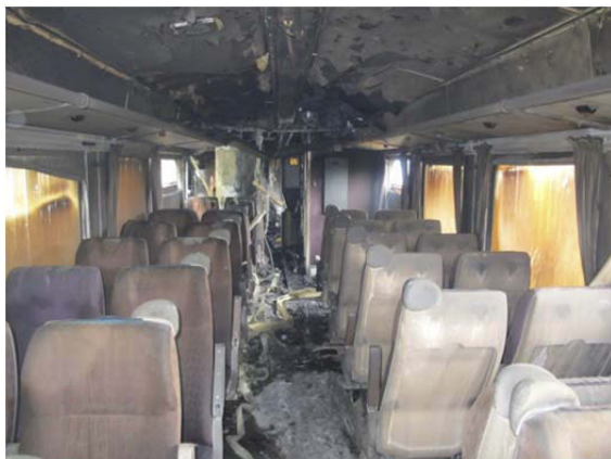
Figur 5: Brannskader i taket.
