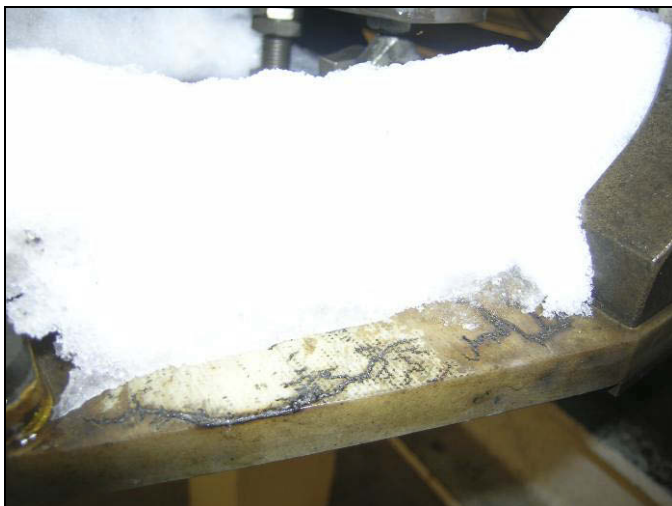
Figur 8: Viser begynnende brannskade på strømvtagers isolasjonsplate. (Det hvite er snø)
