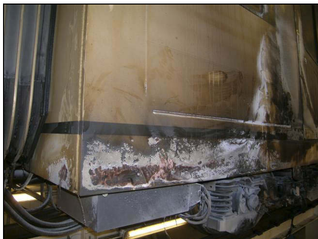
Figur 3: Viser utvendige skader på vognen som brant ved Holmen stasjon, januar 2010
