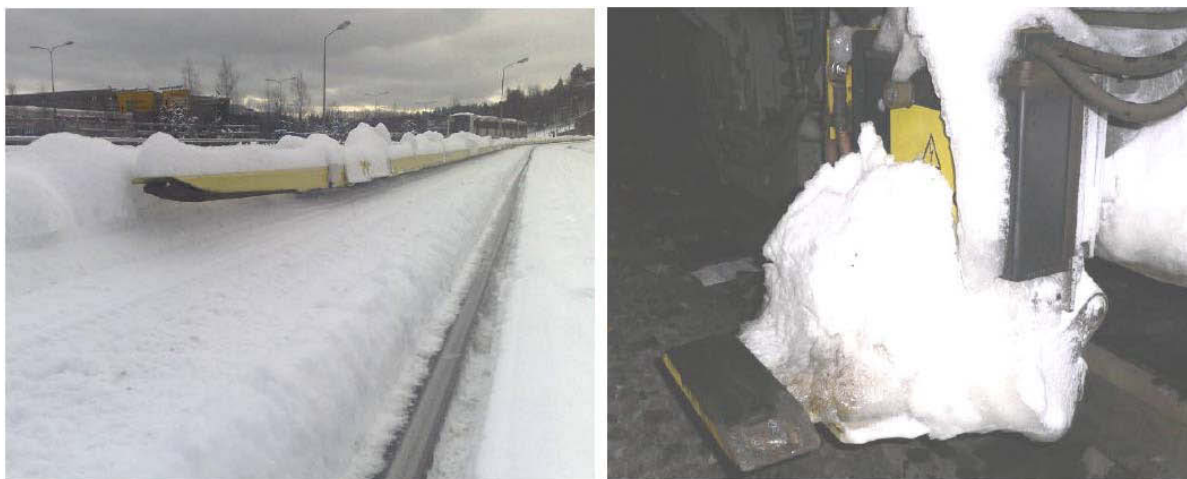
Figur 26 og 27: utfordringer med snø mellom skinnnettopp og strømskinne.
