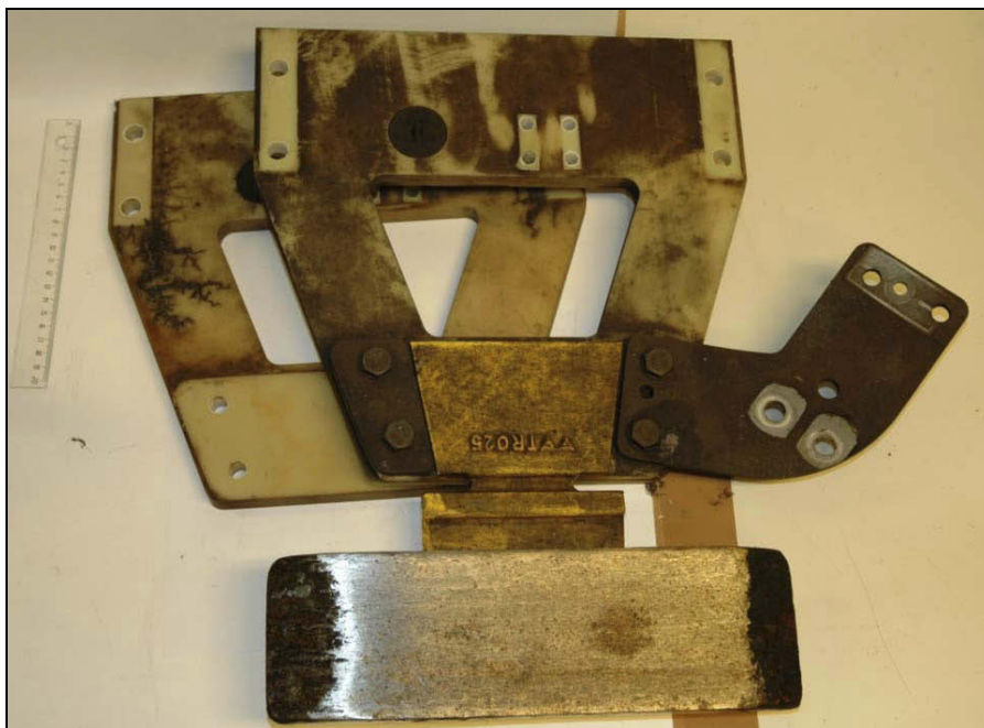
Figur 11: Oversiktsbilde av de to undersøkte isolatorplatene/strømvogterne. Sledesko vises i nederste bildekant.
