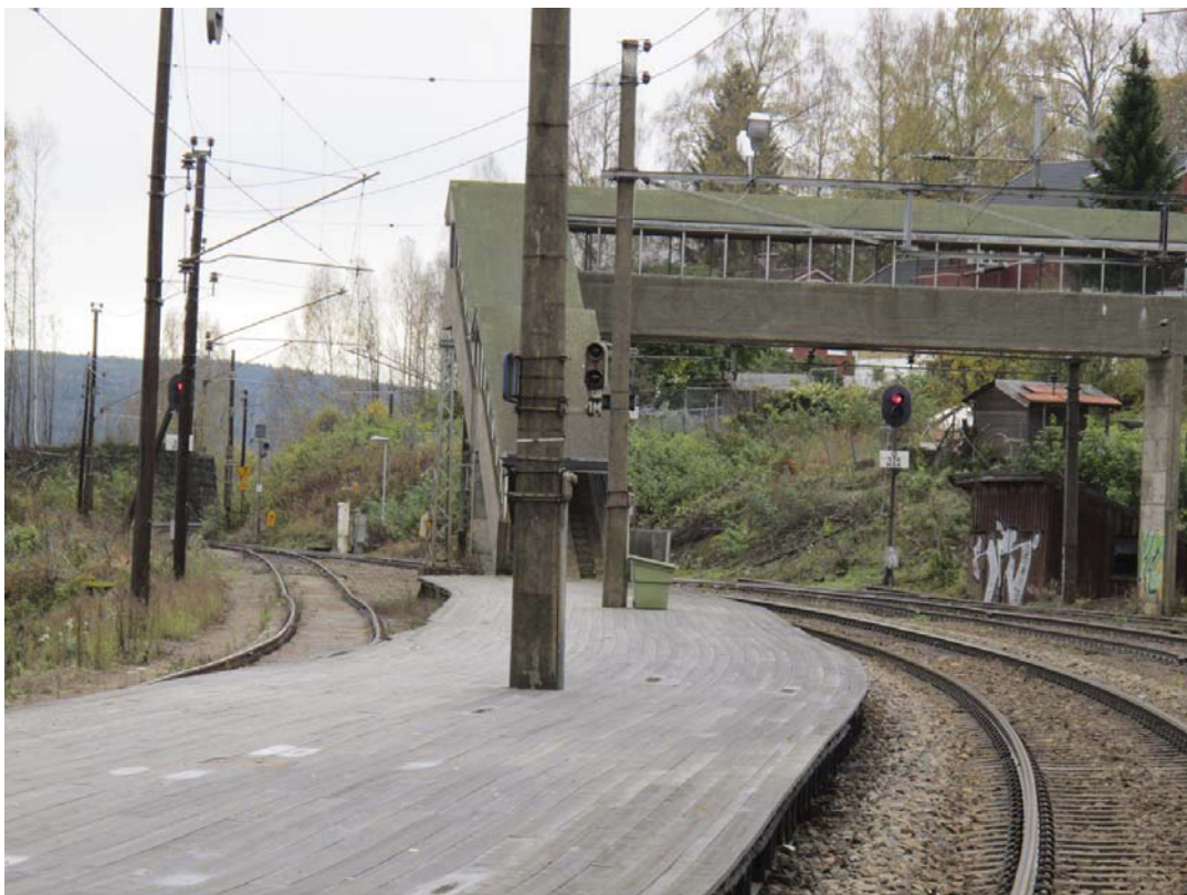
Figur 2: Viser togsporsignalet i spor 1. Utkjørhovedsignal M er skjult bak mast og gangbro.
