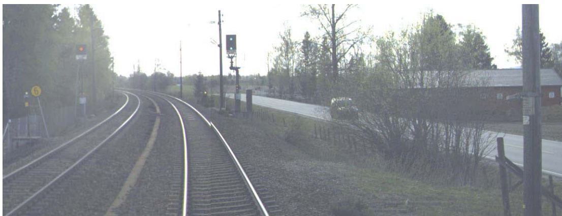
Figur 5: Asper stasjon, til høyre i bildet er det adkomst fra veien til jernbanespetet. (Kilde: Målevognsbilder tatt av Jernbaneverket i 2008)
