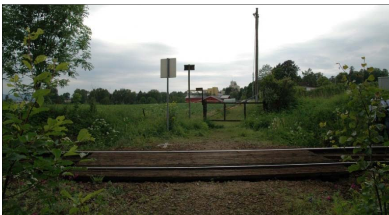
Figur 2: Planovergangen sett fra siden der personen kommer fra [kilde: SHT].
