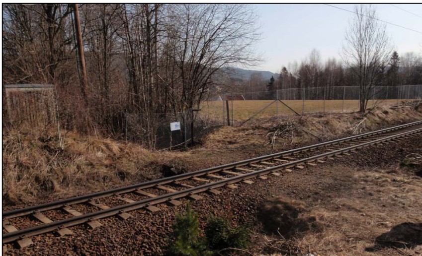
Figur 11: Stenging av planovergang med gjerder.
