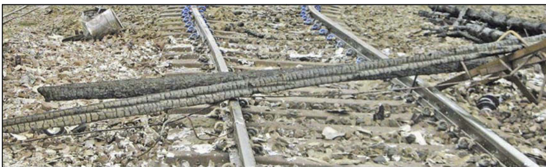
Figur 40: Jordledning ved utgangen av østre snøoverbygg (sveisebøttene ses i bakgrunnen).
