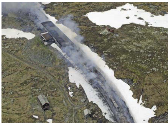
Figur 37: Oversiktsbilde av Hallingskeid etter brannen.
