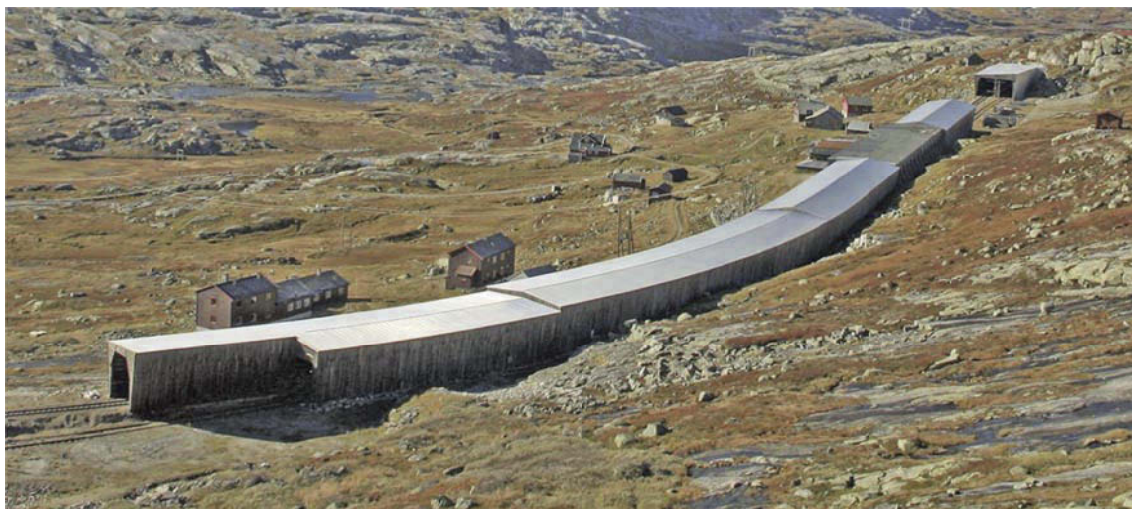
Figur 36: Hallingskeid stasjon og snøoverbygg. (Foto: Willy Koch - 2007)
