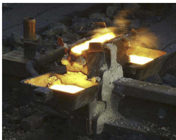
Figur 5-8 Flytende varmt materiale fra termitt-sveis.
