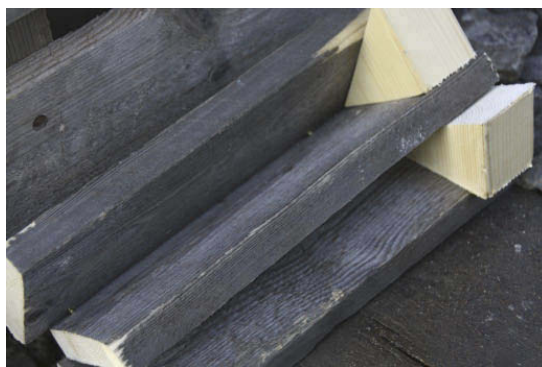
Figur 5-5 Vinkeltrakt (av planker fra Hallingskeid).
