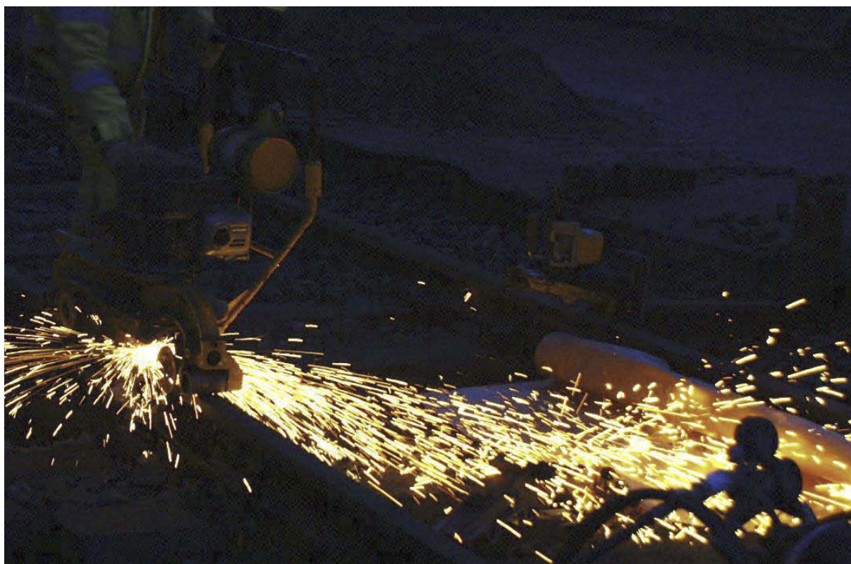
Figur 5-6 Oppsamling av metallpartikler under slip.
