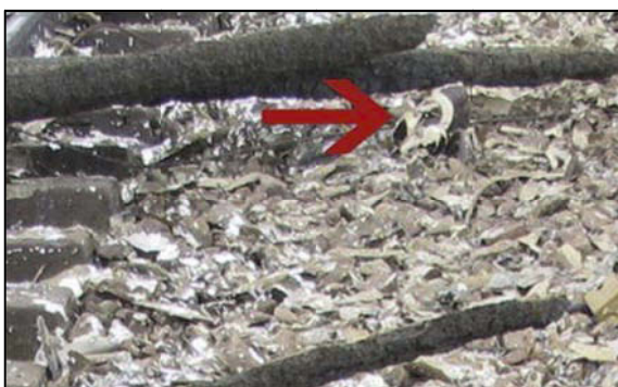
Figur 41: Isolator ved utgangen av østre snøoverbygg.
