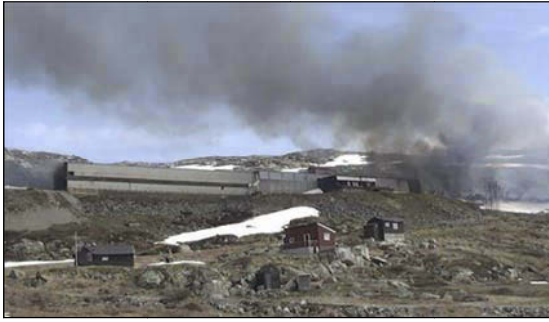
Figur 15: Kl. 12:20 Bilde fra samlingsplassen hvor passasjerene ble evakuert. Det kommer nå røyk ut fra åpningen på snøoverbygget på vestre side av stasjonsbygningen. Dette tyder på at brannen er i ferd med å spre seg til vestre snøoverbygg. (Kilde: Rob van Haaren)
