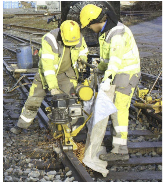
Figur 3-10 Sliping med bruk av sveiseduk (Skien). Vindmaskinen synes i bakkant av sveiserne.
