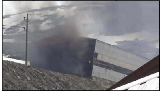
Figur 16: Kl. 12:33 Bilde fra samlingsplassen hvor passasjerene ble evakuert. Det brenner i snøoverbygget som ligger på vestsiden av stasjonsbygningen. (Kilde: Rob van Haaren)
