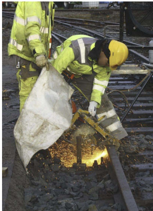
Figur 3-2 Kutting med bruk av sveiseduk (Skien).
