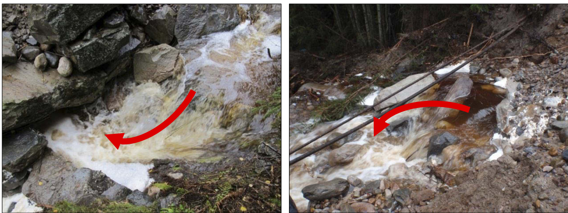
Figur 10: Innløp og utløp av kulvert.
