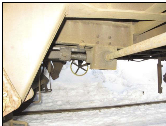
Figur 14: Vogn underside (kilde: SHT).
