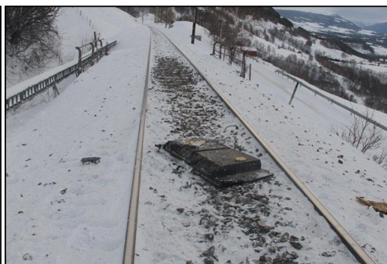
Figur 6: Strail lem Hjelle planovergang - funn G.
