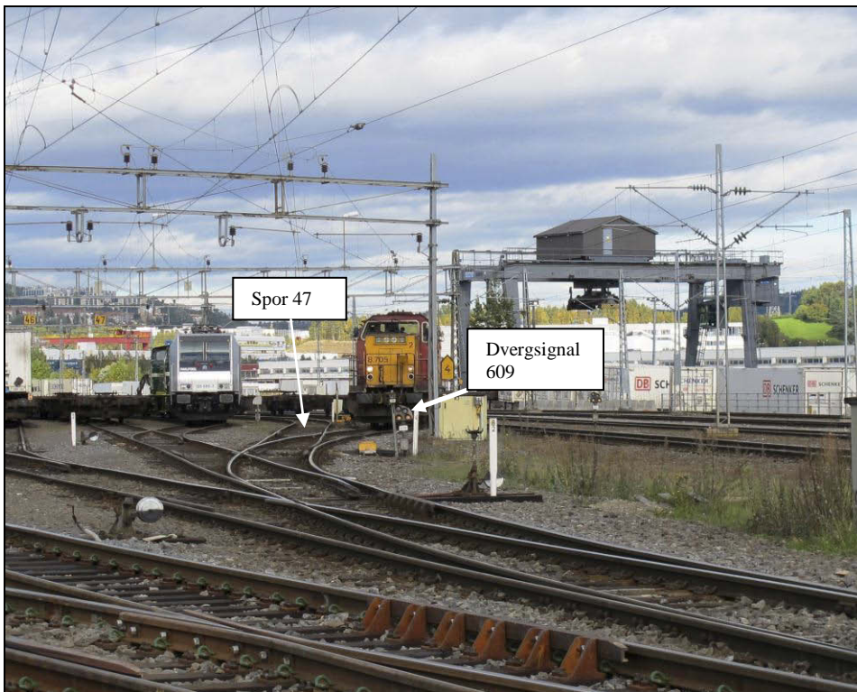
Figur 4: Viser skiftetogveien skiftmaskinen kjørte, og dvergsignal 609.
