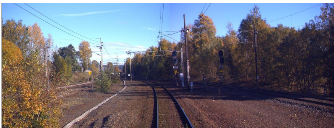
Figur 2: Signal L213 Alnabru. Foto: Jernbaneverket
