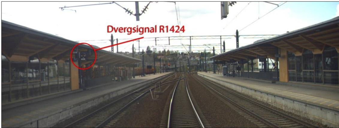
Figur 3: Høyt plassert dvergsignal R1424 på Lillestrøm. Foto: Jernbaneverket
