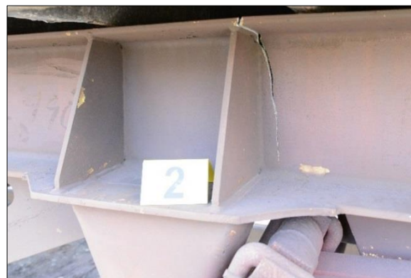
Figur 11: Sprekkdannelse i langbjelke ved venstre bakhjul. Foto: SHT
