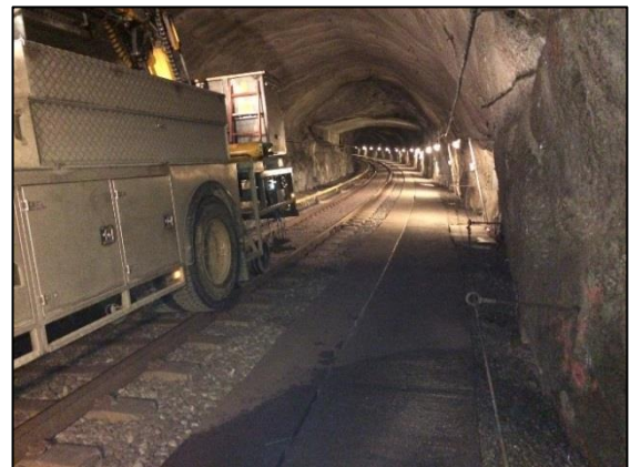
Figur 4: Ledningsbilen etter stopp. Foto: Sporveien Oslo AS
