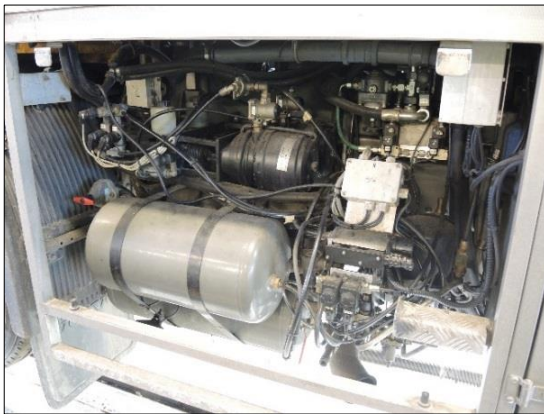
Figur 6: Skap med bremseutrustning. Foto: SHT
