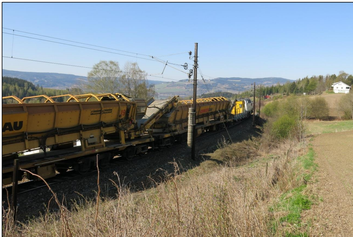
Figur 6: Kontaktledningsmast. Foto: SHT
