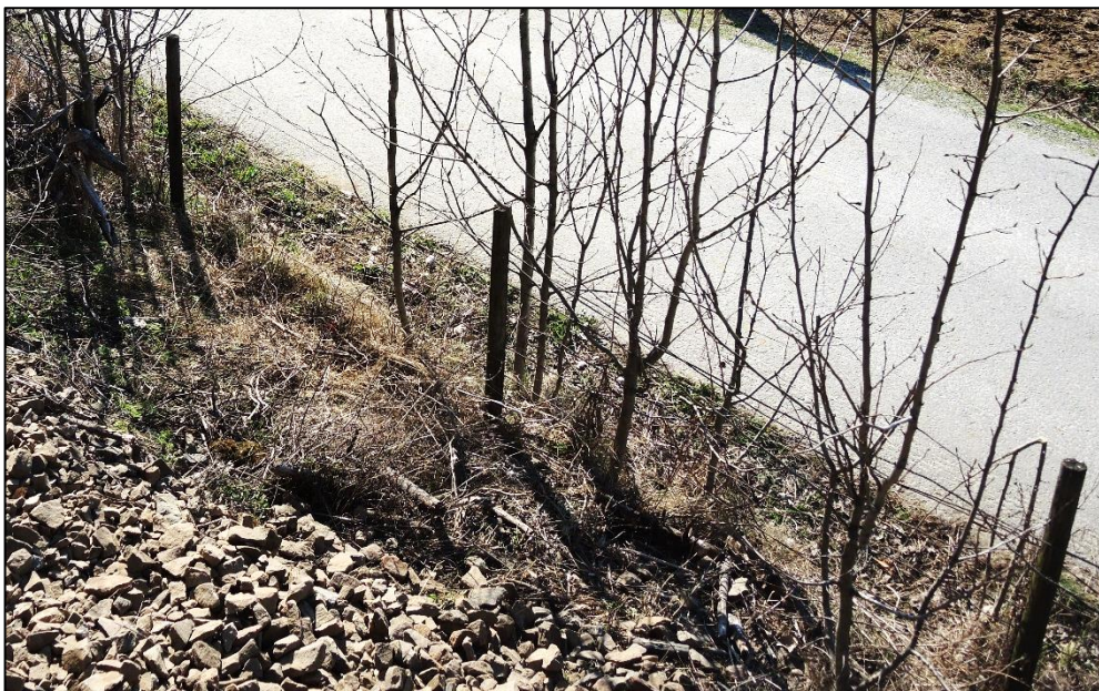
Figur 5: Gjerde som skiller jernbanetrasé fra veg. Foto: SHT
