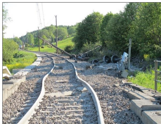
Figur 20: På Nes elvebru (retning syd). Foto: SHT
