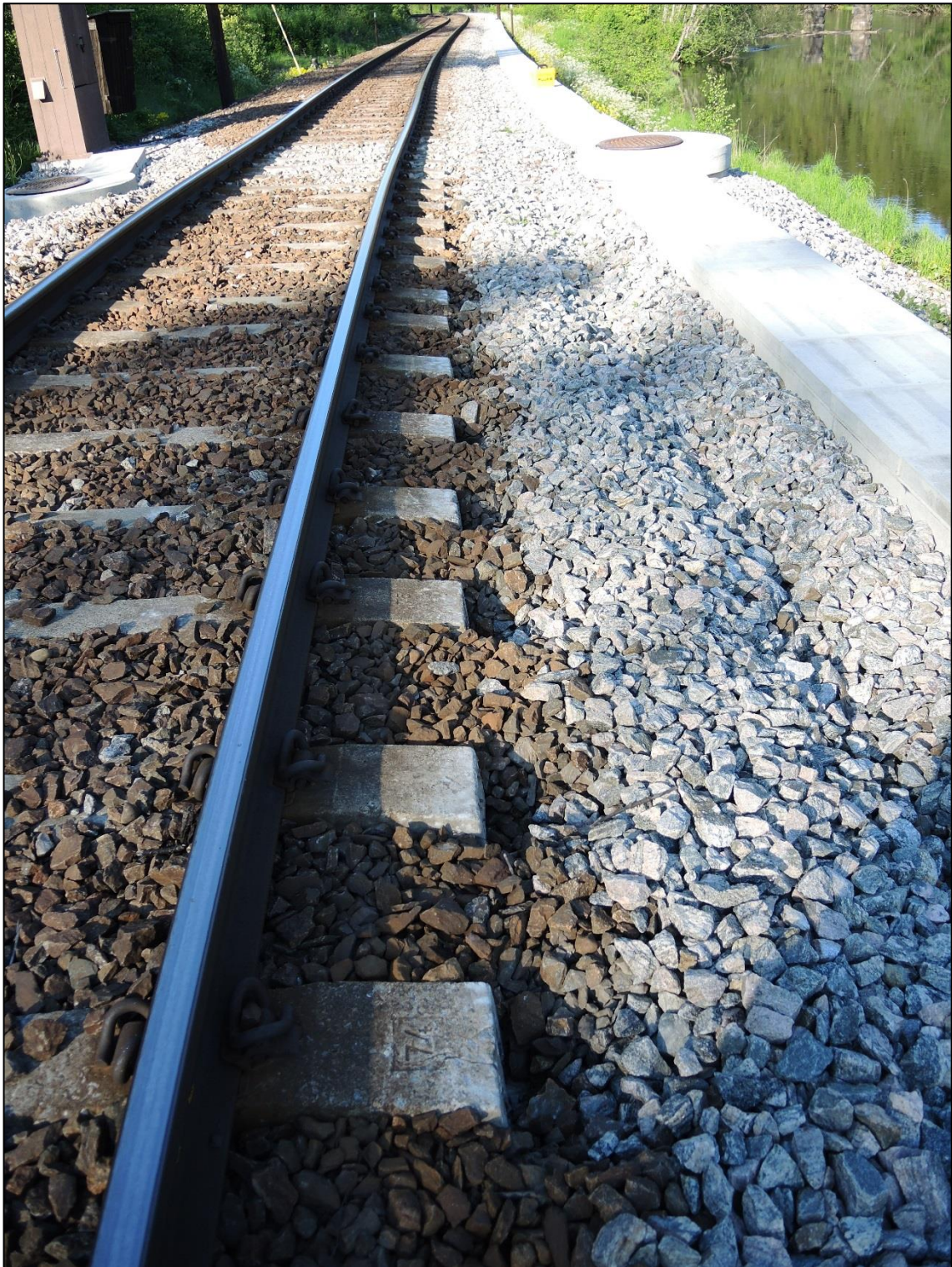
Figur 24: Setning mellom kummene før solslyng (tatt i retning mot nord). Foto: SHT
