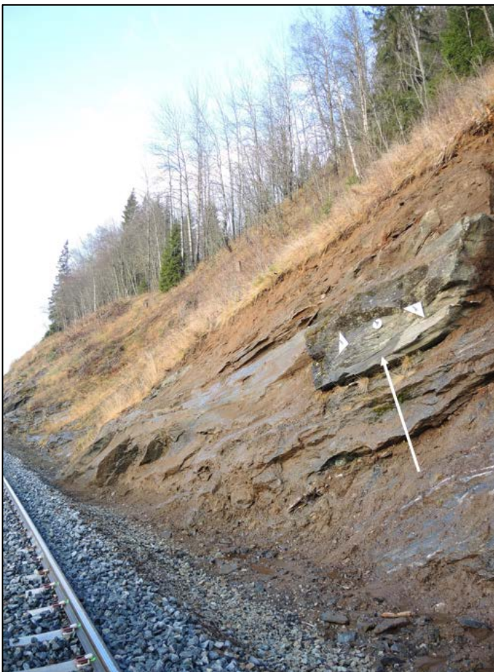
Figur 6: Sikring av sideterrenget. Foto: SHT
