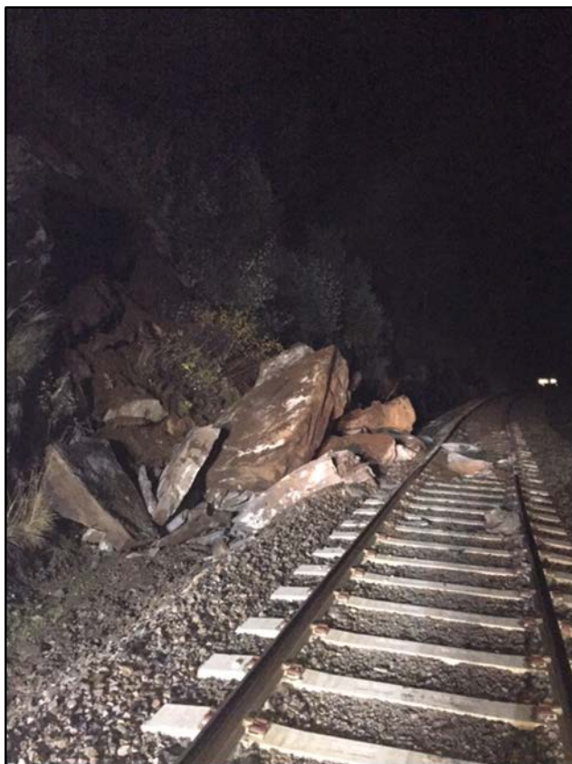
Figur 3: Utraste steinblokker. Foto: NSB Teknikk, Berging og Beredskap
