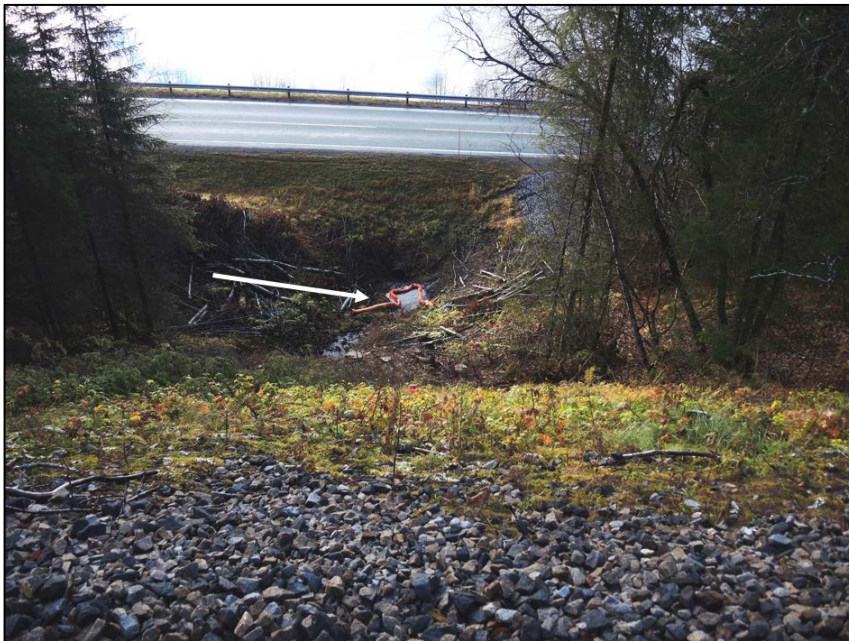
Figur 2: Skråningen ned mot E6 fra stedet hvor togsettet stoppet. Pilen viser linsen som ble lagt ut. Foto: SHT
