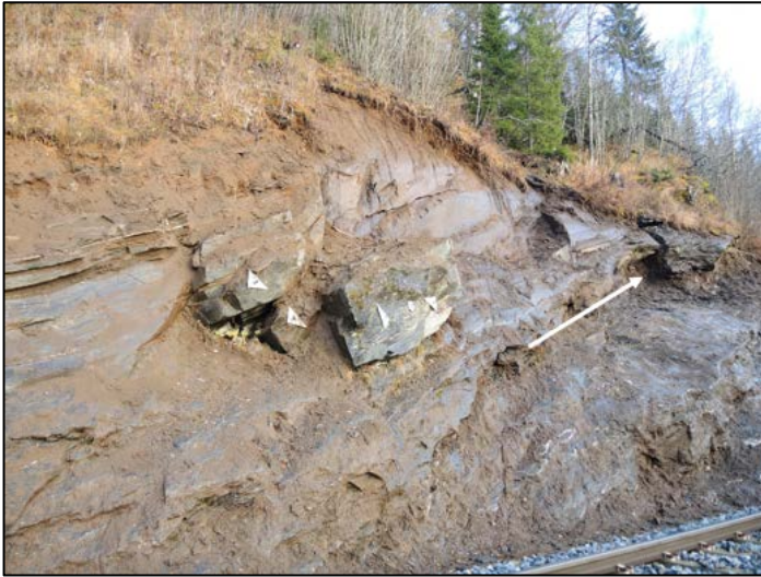
Figur 10: Steinblokk som er i ferd med å bli presset ut. Foto: SHT
