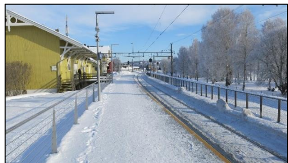
Figur 3: Fetsund stasjon sett mot Kongsvinger. Foto: SHT
