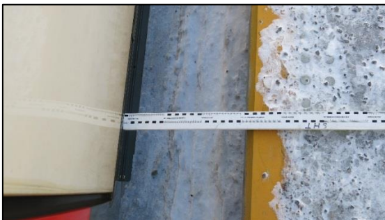
Figur 5: Avstand mellom togsiden og plattform 1 på Fetsund stasjon. Foto: SHT
