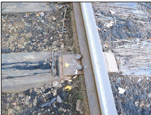
Figur 7: Skinneinnfesting med svillespiker. Foto: SHT
