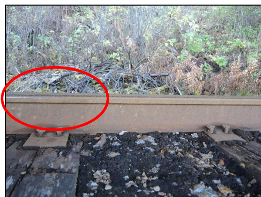
Figur 14: Merker på innsiden av skinnehodet. Foto: SHT
