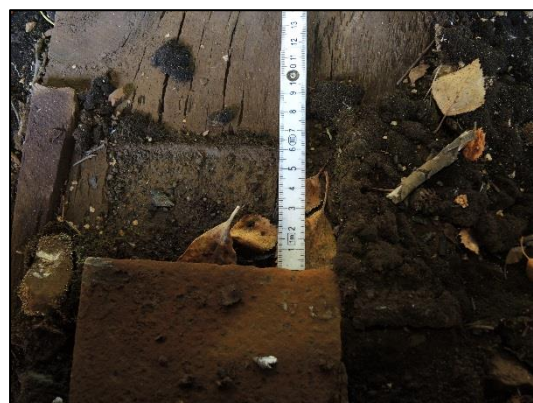
Figur 11: 6 cm sporutvidelse. Foto: SHT
