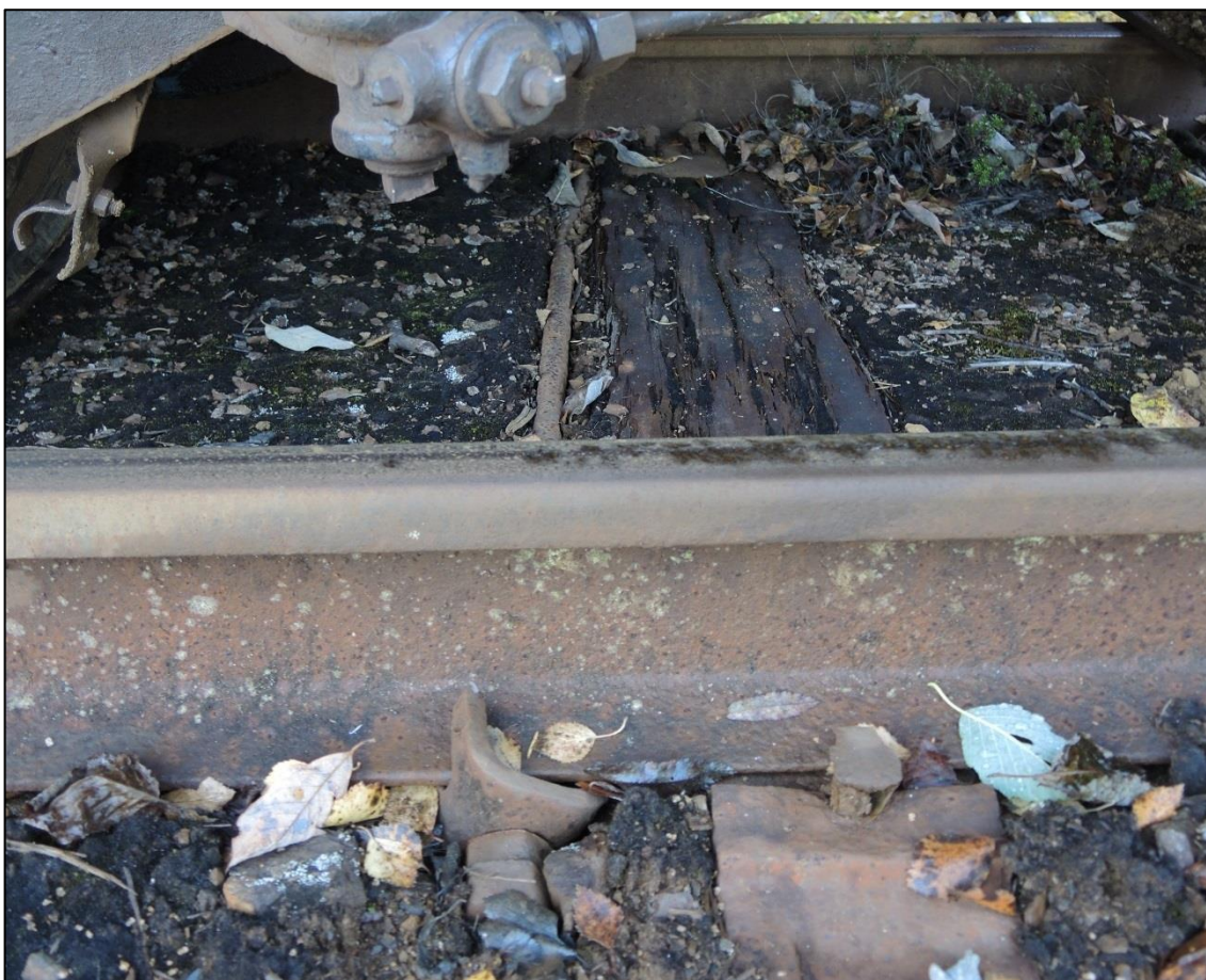
Figur 9: Sporet sikret med strekkbolt. Foto: SHT
