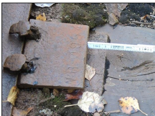
Figur 10: 3 cm sporutvidelse. Foto: SHT
