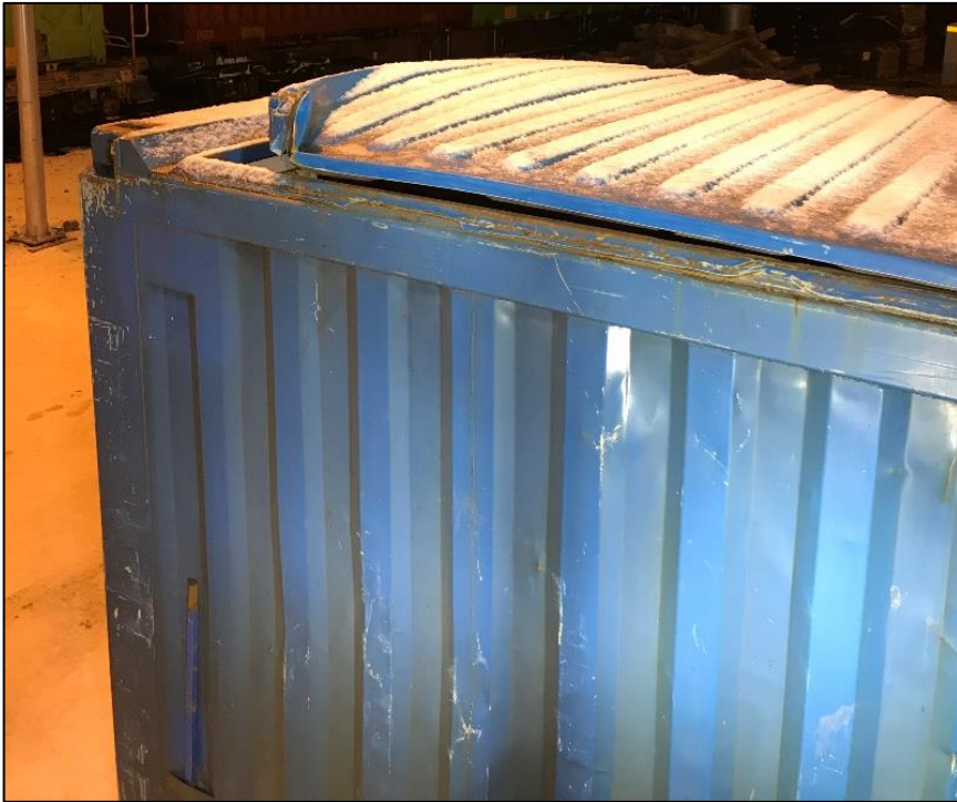
Figur 5: Skader containertak. Foto: SHT
