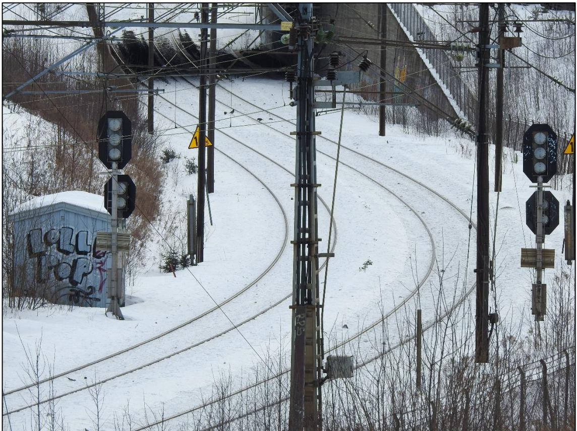
Figur 2: Kulvert retning Oslo S. Foto: SHT
