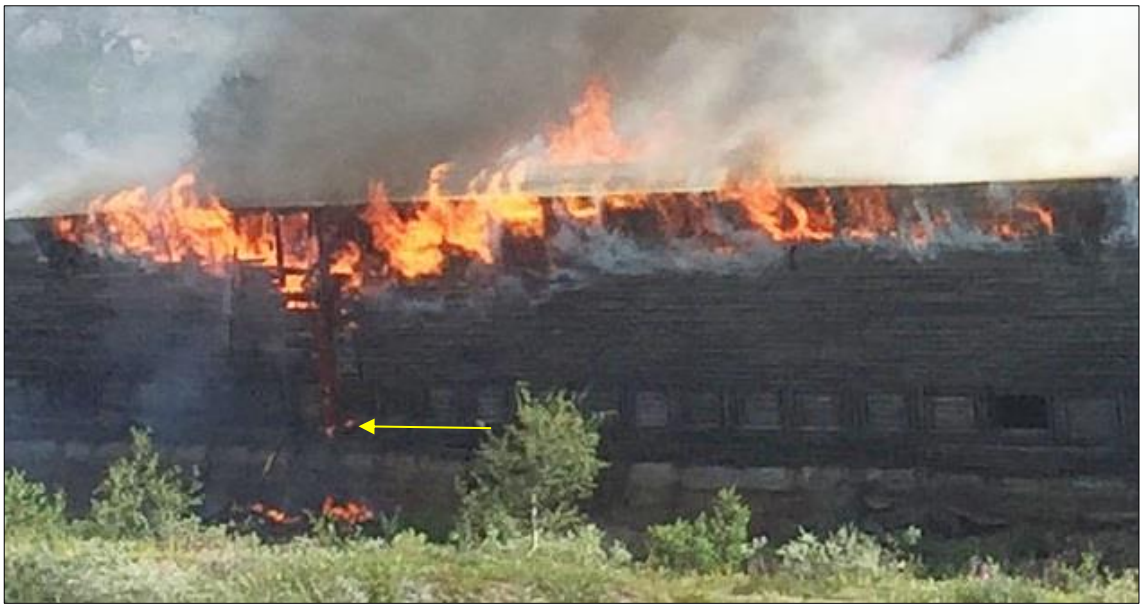
Figur 8: Forstørrelse av brannvifte fra foto kl. 1120 viser brannens laveste punkt på bakkenivå. Foto: Vitne
