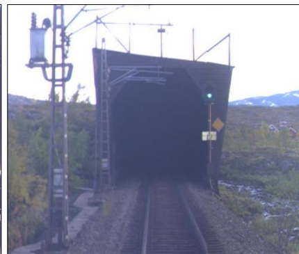
Figur 5: Åpning mot nord med forsignal, km 39,132. Foto: Bane NOR SF målevogn
