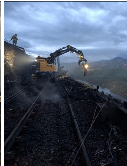
Figur 22: Brannslukking og mekanisk fjerning av rester natt til 9. august. Foto: Bane NOR SF
