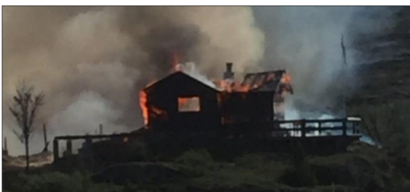
Figur 12: Brannforløp kl. 1254. Hele snøoverbygget og store deler av en nærliggende hytte hadde brent ned. Foto: Vitne
