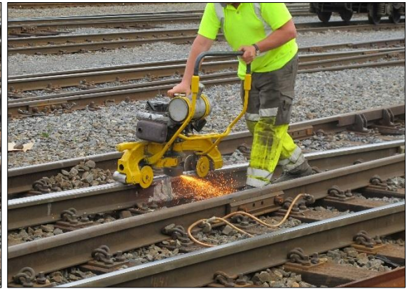
Figur 42: Finsliping på Alnabru 22.6.2011, kl. 13:59. Illustrasjonsfoto: SHT
