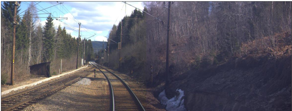
Figur 4: Lokomotivet stanset i sporveksel 1 på vei ut av Roa stasjon (ca. km 57,340). Foto: Målevognbilder fra Bane NOR SF
