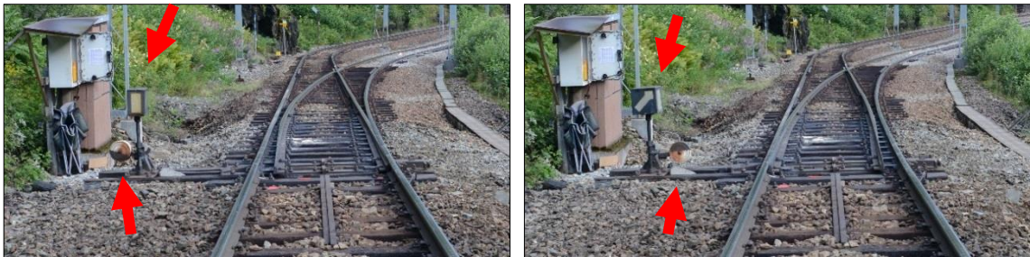
Figur 17: Sporvekselposisjoner mot spor 1 og mot spor 2. Vekselodd og anviser er markert. Foto: SHT
