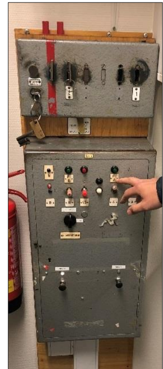
Figur 14: C-lås og stillerapparat 3 på Berekvam. Foto: SHT
