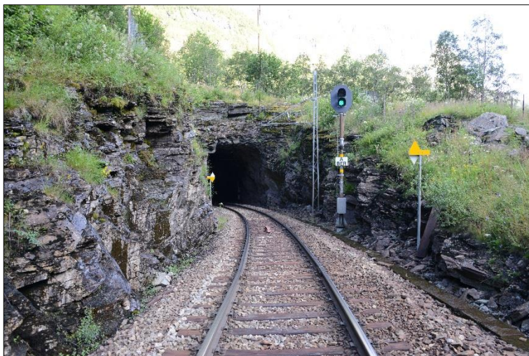
Figur 10: Innkjørhovedsignal HSA Berekvam st. Foto: SHT
