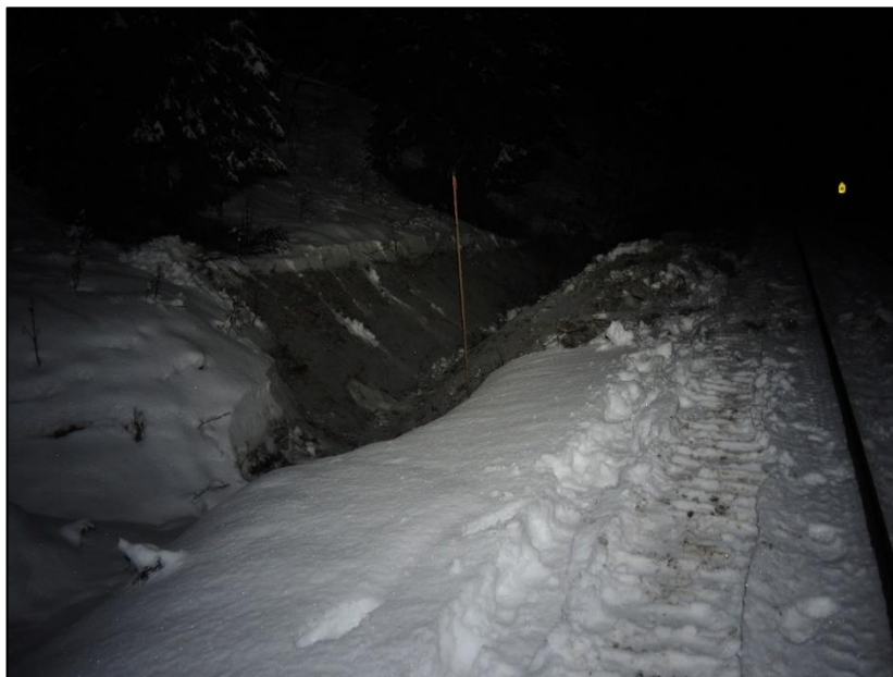
Figur 13: Grøft som ble etablert. Stikke markerer stikkrenne. Foto: SHK
