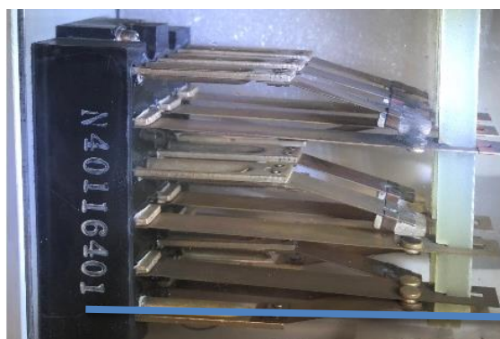
Figur 12: Kontakter på PN-150BL sett fra siden. Foto: SHK
