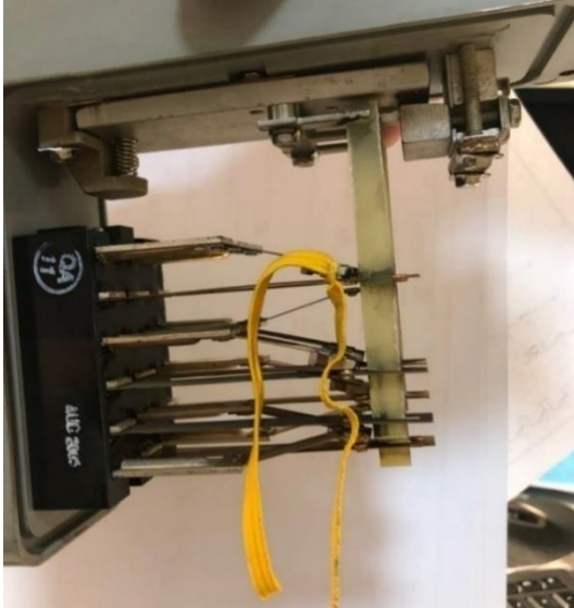
Figur 25: Simulerer «låst» posisjon med tråd/strikk på kontakt 1F på LO relé. Foto: Sporveien AS
