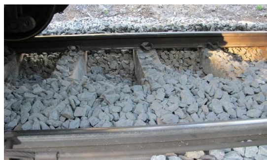
Figur 8: Lite pukkt rundt svillene. Foto: SHK
