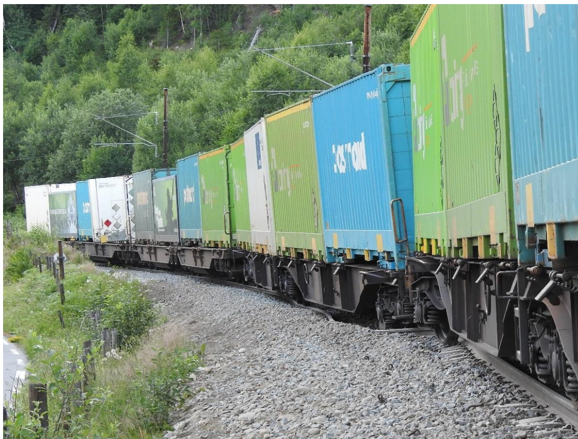
Figur 1: Avsporede vogner i tog 4842 og skader på skinnene. Foto: SHK
