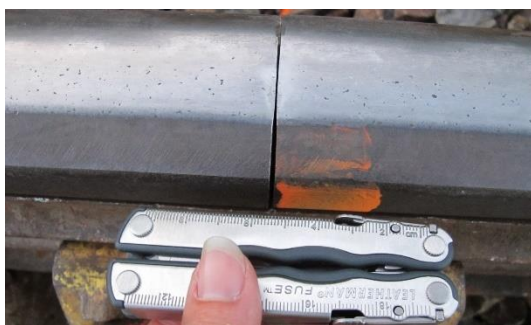
Figur 7: Tett/lukket i laskeskjøten. Foto: SHK
