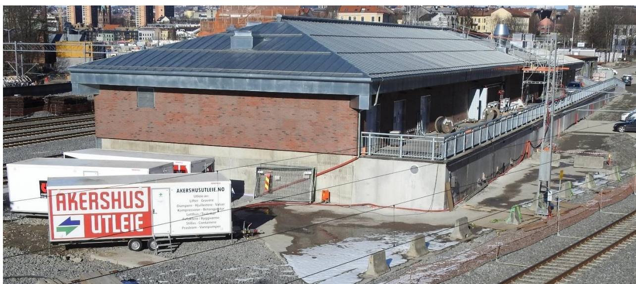
Figur 16: Oversikt over området hvor sammenstøtet skjedde etter at brakkene er flyttet lengre unna sporet og betongblokker er satt opp mot sporet. Foto: Bane NOR SF
