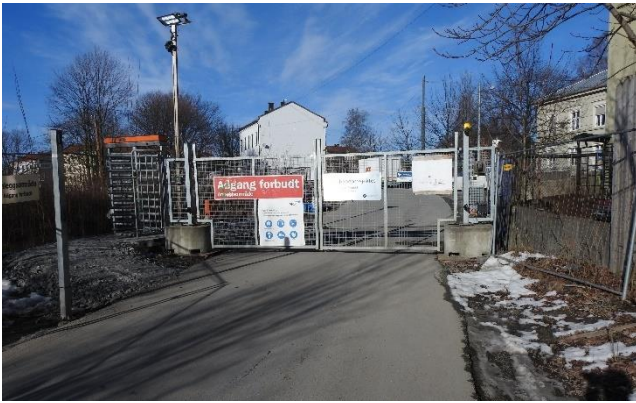
Figur 9: Porten inn til anleggsområdet. Foto: SHK
