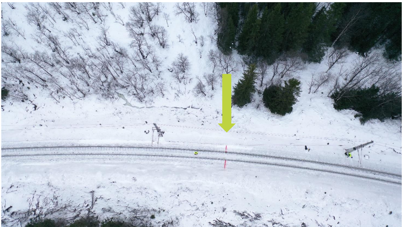
Figur 3: Avsporingsstedet ved km 14,280 markert. Foto: SHK
