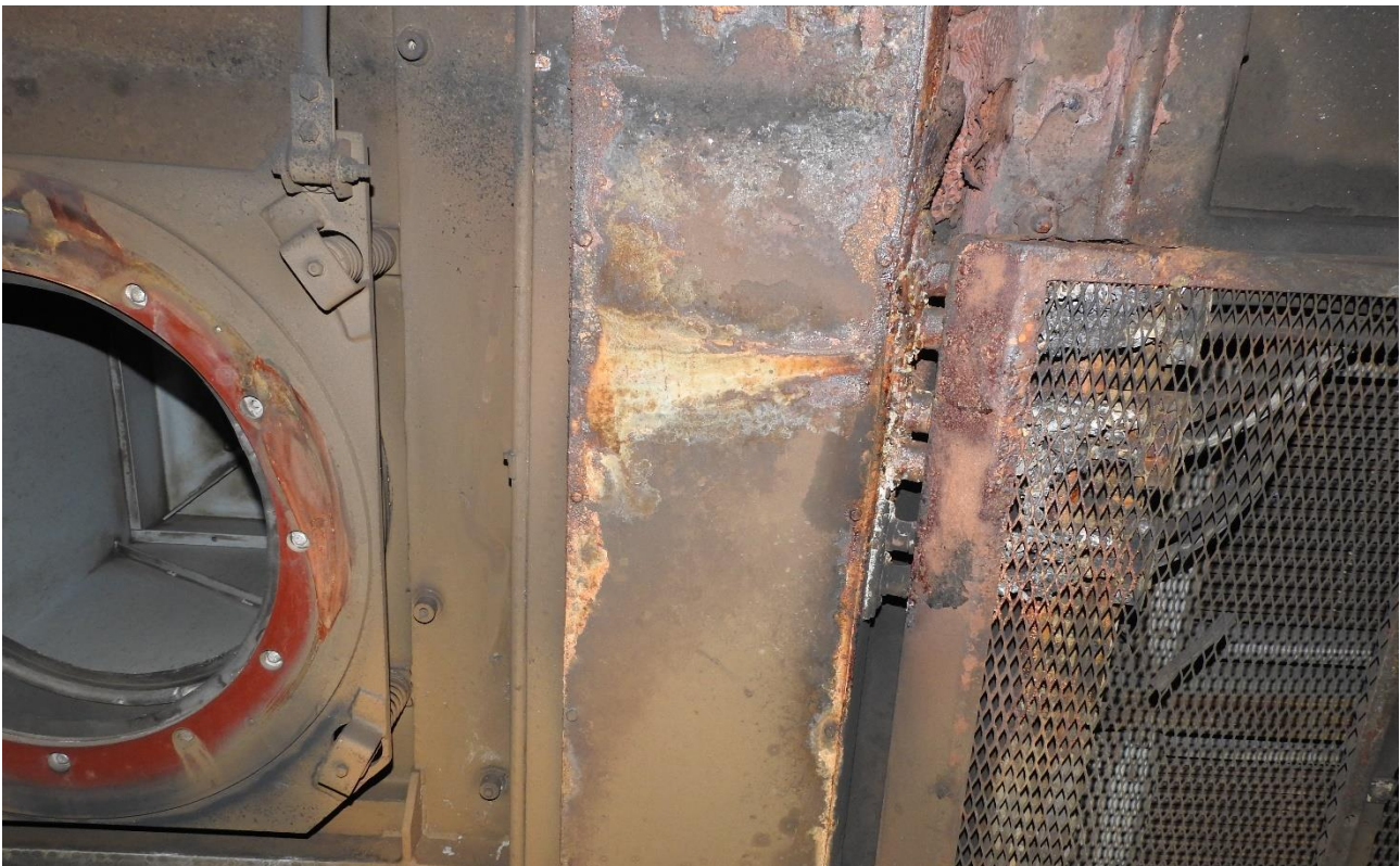
Figur 25: Utvendig gulv i lokomotivkasse. Foto: SHK
