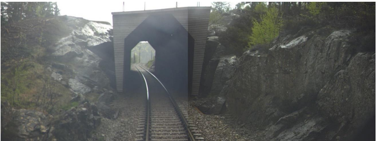
Figur 2: Snøoverbygget før brannen ved km 263,9. Foto: Målevognbilette, Bane NOR SF
