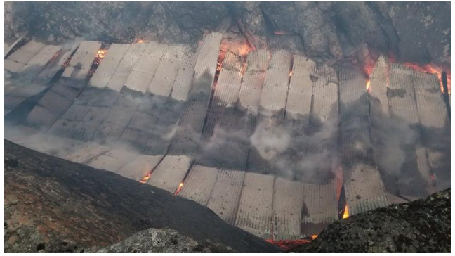
Figur 15: Sotdanning på takplatene. Foto: Østre Agder Brannvesen
