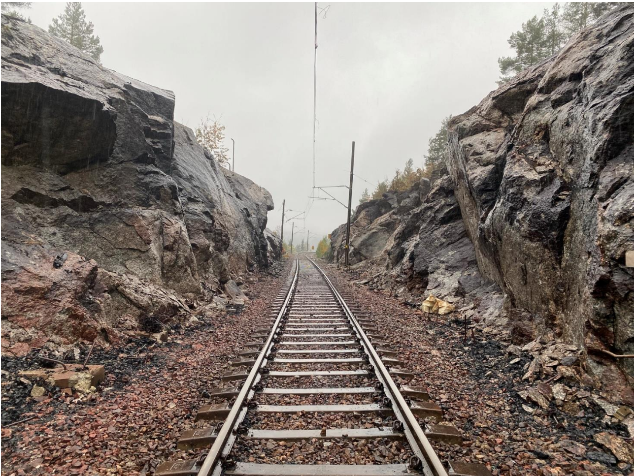
Figur 16: Restane etter snøoverbygget er fjerna. Foto: SHK
