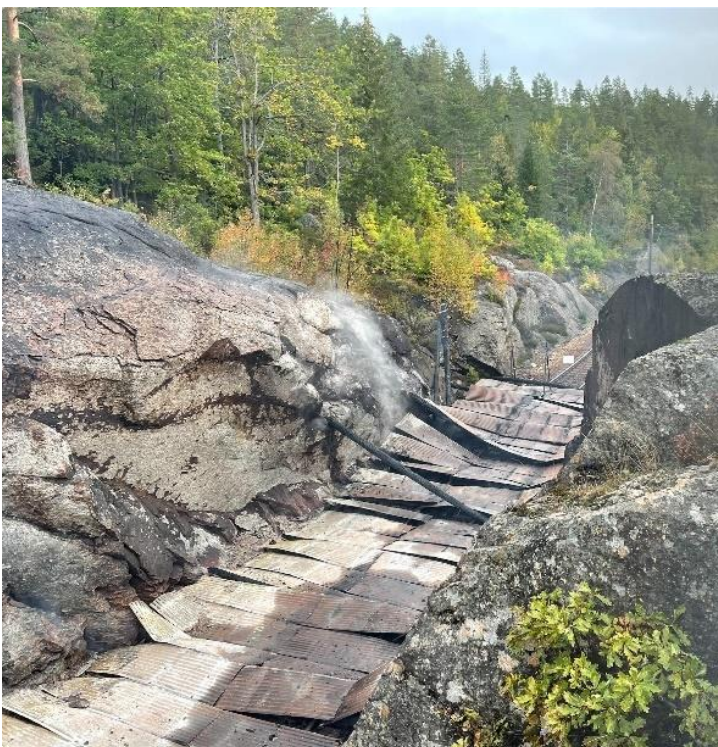
Figur 5: Takplatene frå snøoverbygget. Foto: Bane NOR SF
