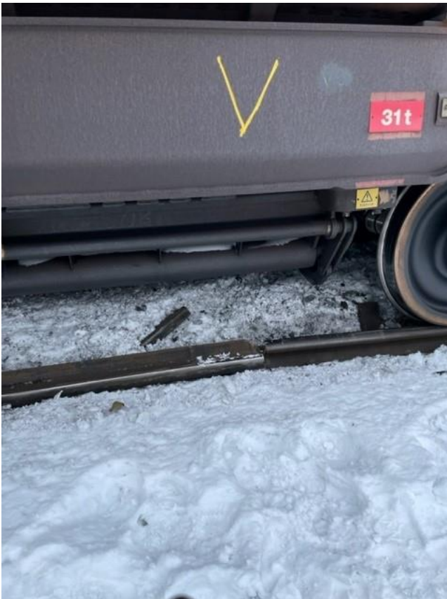
Figur 15: Første skinnebrudd i togets fartsretning. Foto: Bane NOR SF
