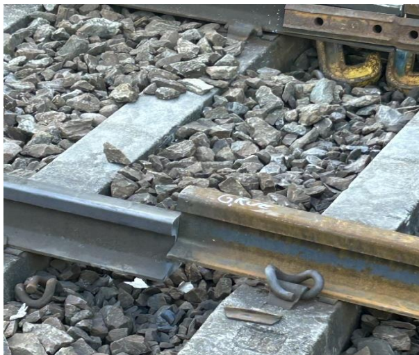
Figur 8: Skinneskjøten før montering av midlertidige lasker. Foto: Bane NOR SF
