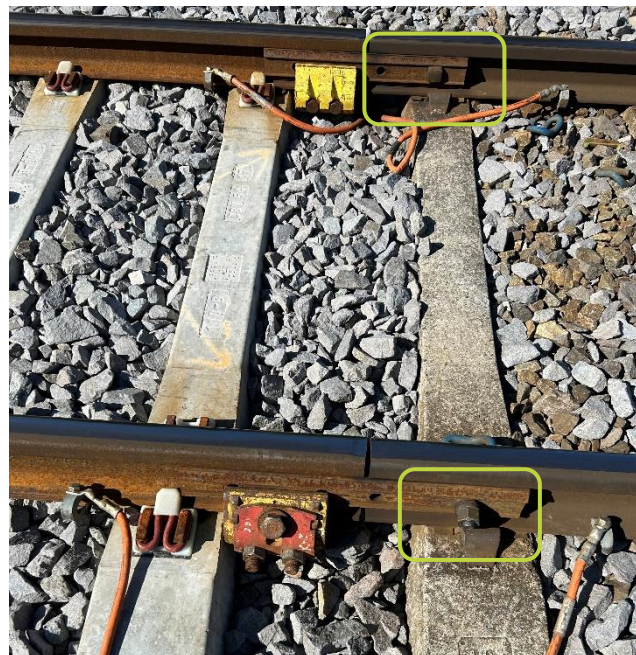
Figur 10: Montert laskebolt på midlertidig lask ved sporveksel 1 på Grua. Foto: Bane NOR SF
