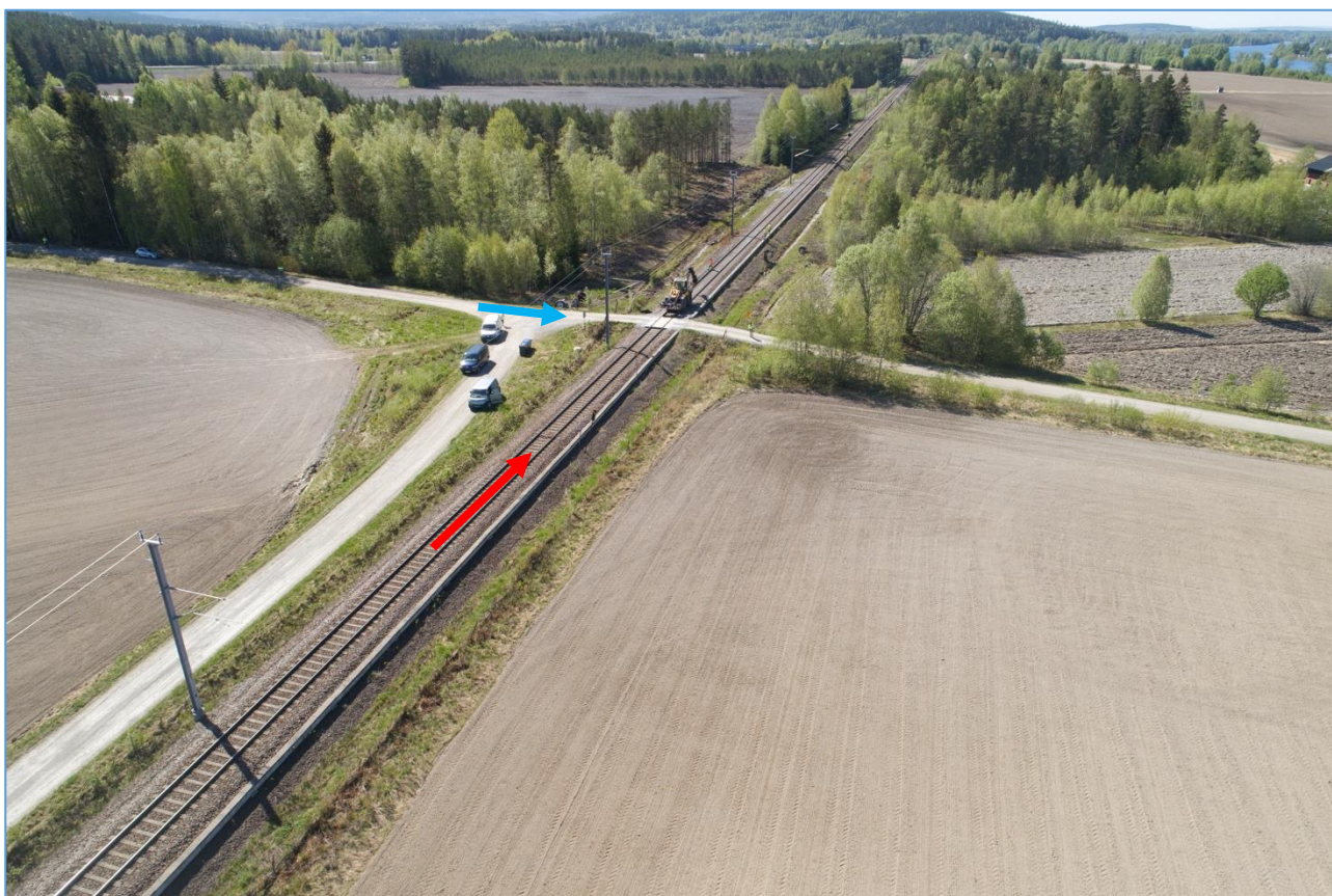
Figur 5: Dronefoto av planovergangen. Den blå pila viser retninga til traktoren. Den raude pila viser retninga til toget. Foto og påteikning: SHK
