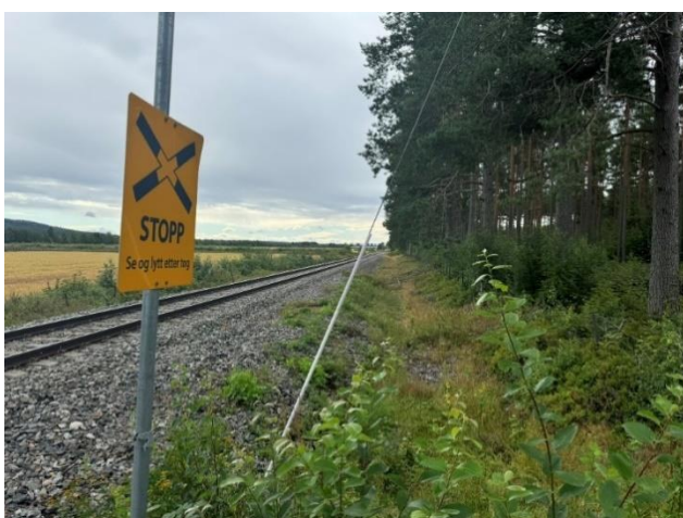
Figur 9: Sikt i retning mot Elverum (mot toget). Foto: SHK
