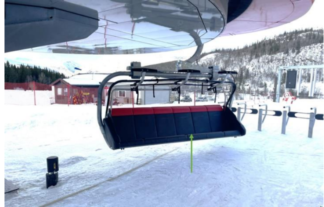
Figur 12: Målt setehøyde var ca. 56 cm. Bildet viser også vindskjerm i oppreist posisjon. Foto: Politiet. Påtegning: SHK
