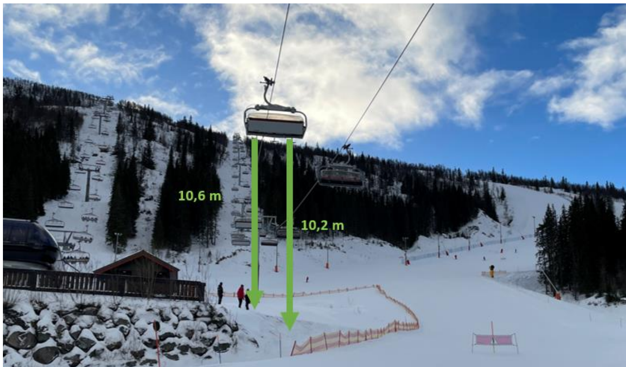
Figur 5: Fallsteder med markering for høyde fra bakken og opp til underkant av heisstolen, sett oppover heistraseen. Foto: Politiet. Påtegning: SHK
