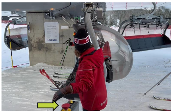
Figur 15: Utsikt fra heisfører inne sin posisjon på ulykkestidspunktet, rett frem. Pil viser utvendig kontrollpanel. Foto: SHK
