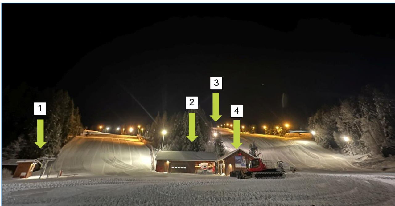
Figur 8: Dalstasjonene for Mellomheisen (1), Hovedheisen (4) og garasjeanlegg og verksted (2) samt toppstasjon med vendejul (3). Foto: SHK
