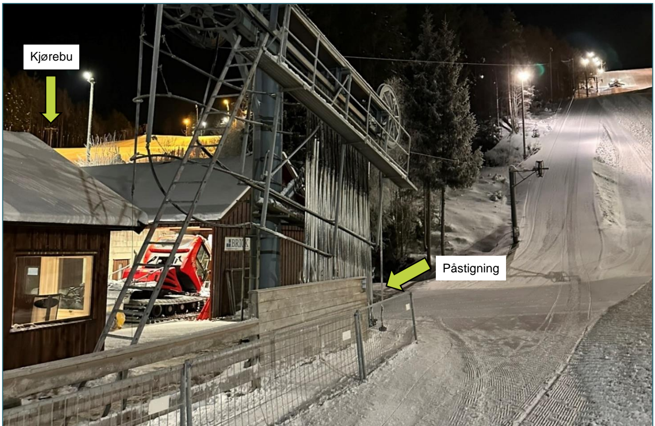
Figur 9: Dalstasjonen med markering av kjørebua og påstigningsområde. Garasjeanlegg og verksted i bakgrunnen. Foto og påtegninger: SHK
