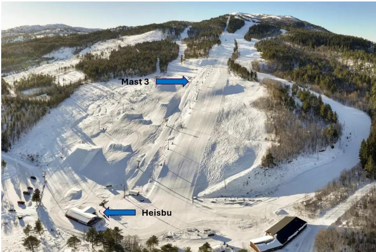
Figur 2: Oversikt over alpinanlegget. Foto: Surnadal alpinsenter AS, med påskrift frå SHK
