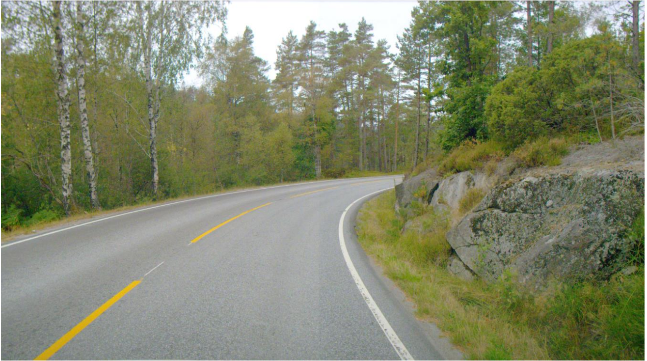
Figur 10: Veistrekningen hvor ulykken inntraff. Foto: Vegkart, Statens vegvesen
