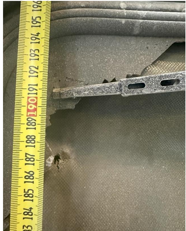
Figur 7: Hull i vinduet på bakhjørnen til beltetvognen. Foto: SHK
