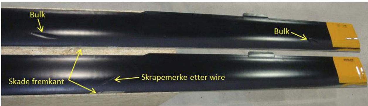
Figur 2: Hovedrotorbladene lagt ved siden av hverandre med undersiden opp. (Foto: Helitrans)
