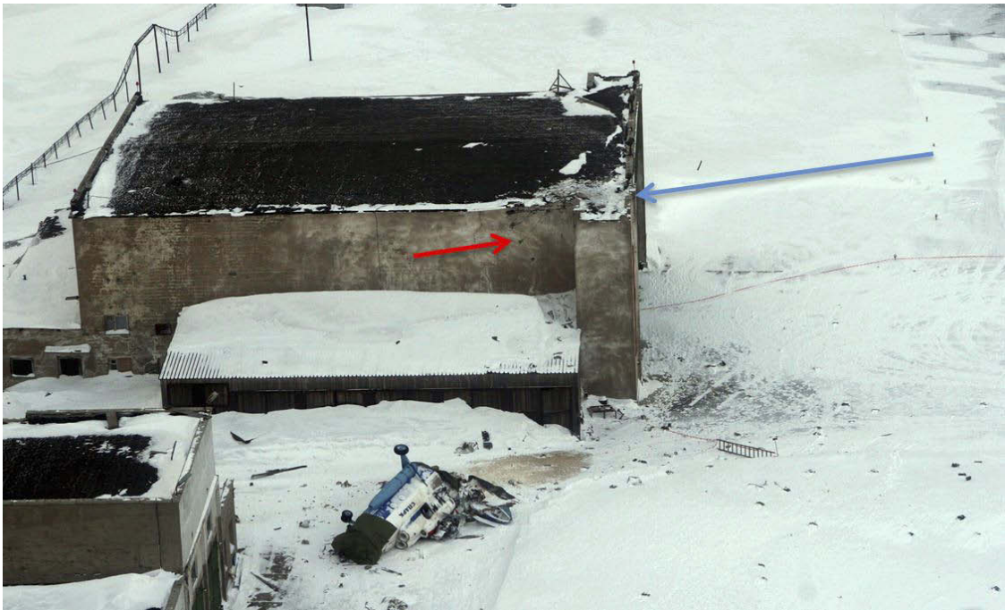
Figur 6: Hangaren sett fra syd. Blå pil indikerer retningen helikopteret kom. Rød pil viser slagmerker fra hovedrotoren i hangarveggen. Vraket ligger på bakken i forgrunnen på bildet. Mellom hangaren og vraket sees store mengder drivstoff blandet med snø.
