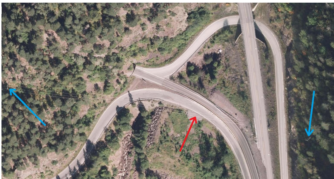
Figur 13: Bilde fra området med havaristedet (rød pil) og kraftlinjemastene (blå pil) markert. Lyktestolpene og ledningen mellom disse er ikke med på bildet. E16 går nord-sør i bildet. Arbeidet med havari-/nødutstyrsloppen sør for tunnelen var ikke påbegynt da bildet ble tatt. Kilde: Nasjonal Vegdatabank (biler på veiene er fjernet med Photoshop)
