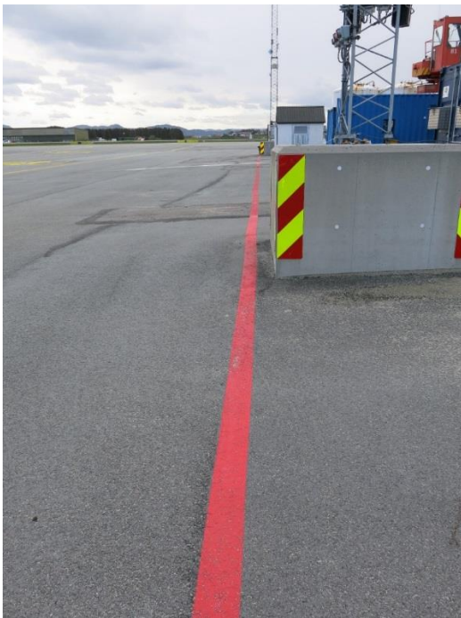
Figur 5: Viser at det ikke er plass til å kjøre mellom rød sikkerhetslinje og avisingsdepot med dagens infrastruktur. Videre vises at lysmastene står plassert ved grensen til manøvreringsområde (jf. 1.10.3.1) Foto: SHT
